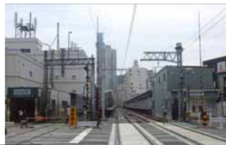
既設線 仮下り線 仮上り線
